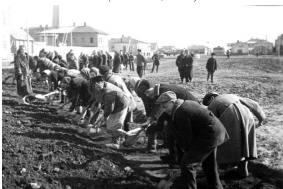
Фото: «Учащиеся средней школы № 8 г. Новокузнецка за ремонтом дороги. Новокузнецк» (1944)
